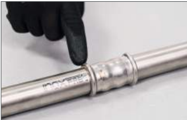
Controllo della pressatura / Checking the press connection
